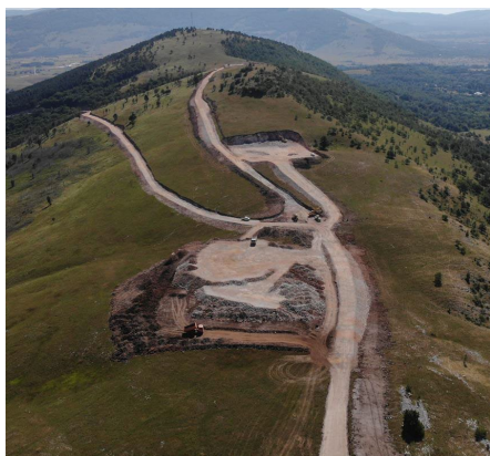
Izgradnja VE Mazin 2
